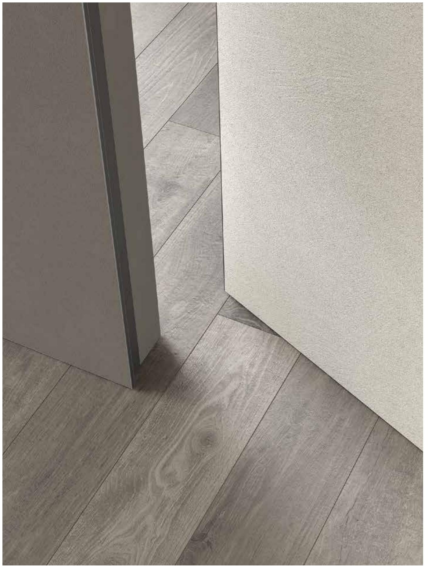
Un telaio filomuro sottile e discreto con un nuovo brevetto. Una struttura intelligente e un incastro perfetto tra falso telaio e cover di finitura. Il falso telaio TWIN SUBFRAME scompare perfettamente nella parete, creando un effetto visivo continuo, senza interruzioni, e lasciando
