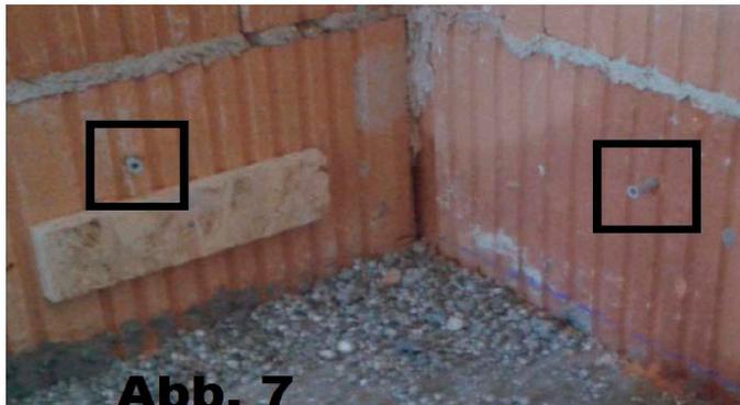
Procedere al fissaggio dei supporti in alluminio alla parete, mediante l'avvitamento delle viti negli appositi fori. Durante questa operazione, aiutarsi con una staggia e piccoli cunei di legno per ottenere un corretto allineamento. Dopo averne verificato il corretto allineamento, riempire gli eventuali spazi risultanti tra essi e i mattoni con la colla di montaggio. Rimuovere la pellicola protettiva dai profili solo a lavori di pittura ultimati e prima della posa della pavimentazione.
