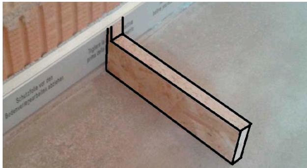
Con l'inserimento di chiodi di acciaio nel sottofondo e nelle dime di montaggio, si provvede al fissaggio della staggia.
